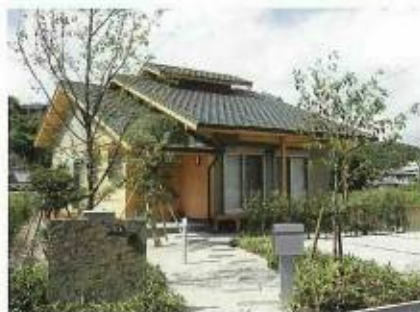
木造住宅施工事例外観
