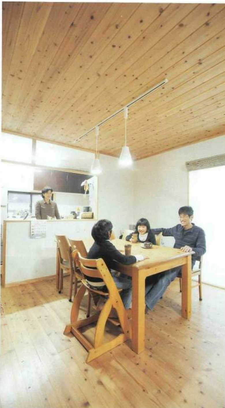
床と天井は杉の無垢材、壁は珪藻土を用いた、自然素材でできた家。「今年の猛暑もエアコンなしで乗り切れました。雨の降る日に窓を閉め切っても扇風機で大丈夫でした」とエアバス効果を実感したそうだ
