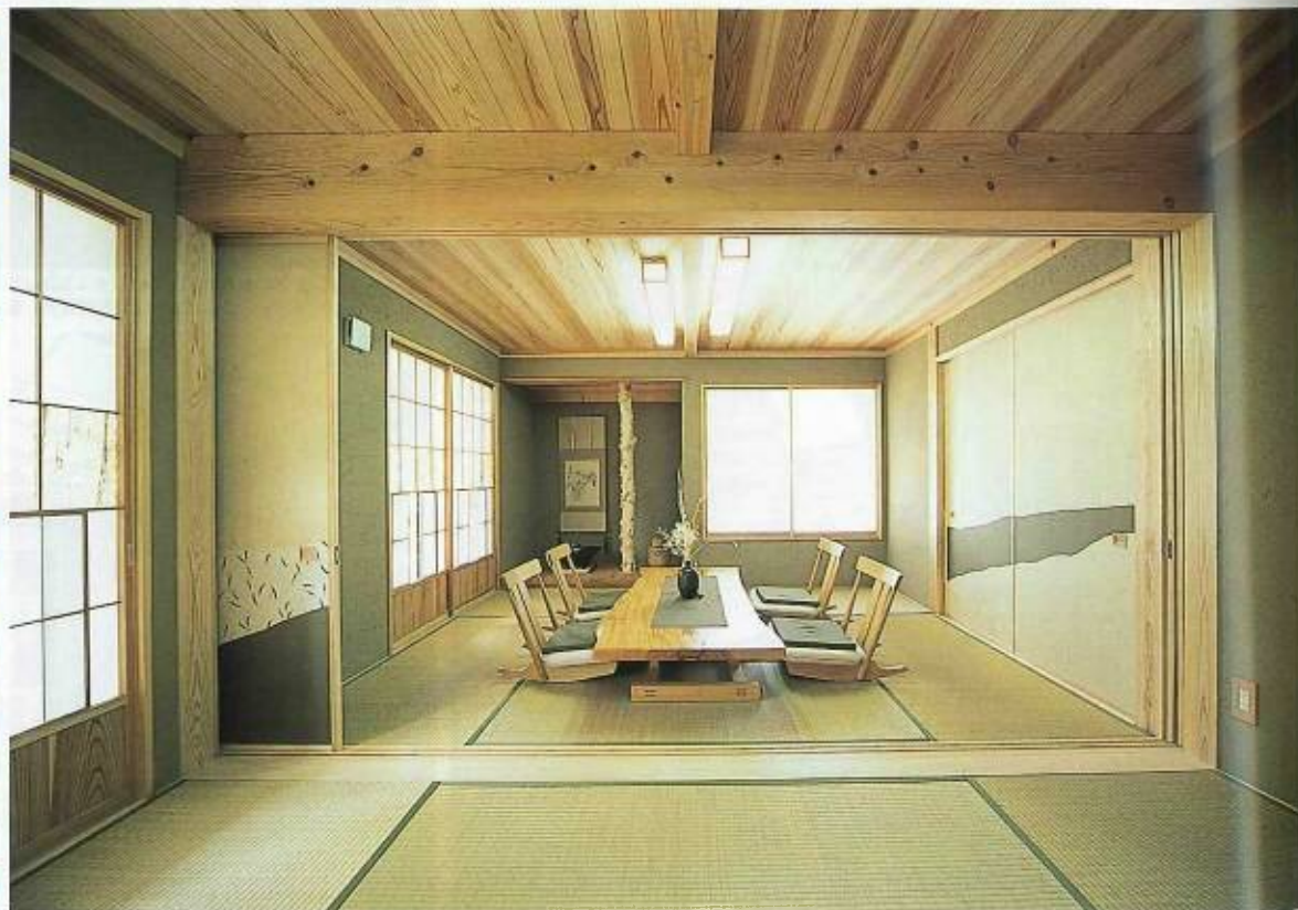
リビングの隣りに和室を配置。廊下がない「広がり間取り」はスペースを有効に使えるうえ、家族の気配を感じながら暮らせるのが魅力。和室の壁は藁を練りこんだ珪藻土。吸湿性に優れ、曇の風合いも出てユニーク。こうぞ（紙の原料となる植物）をアクセントにしたデザイン性の高い猫間障子など建具類はオリジナル
