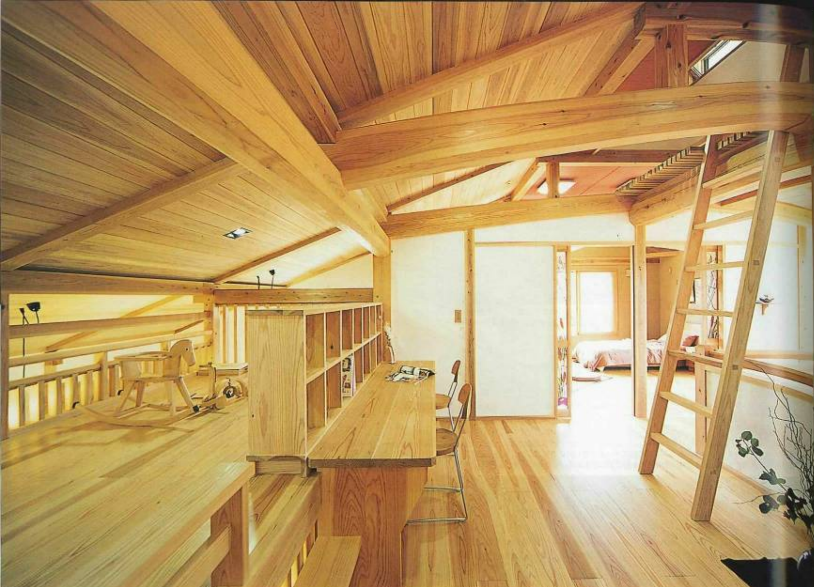
多目的スペースとして使える2階のロフトからはリビングが見下ろせる。子どもの遊び場や家族の図書室にするなど使い方も自在。ちなみにロフト上部にエアバスの特徴でもある越屋根がある。同社では耐震性の高い伝統技術「貫工法」を取り入れ、柱や梁の木組みは釘を使わず込栓で留めるなど職人の技が光る。間近に見るとその木組みの様子がよく分かる。どこもかしこも隠さず見せられる美しい手仕事に感服
