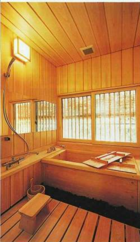
浴室にも無垢木へのこだわりを發揮。木床、壁、天井、浴槽は、すべて香りがよく水に強い檜で仕上げた
