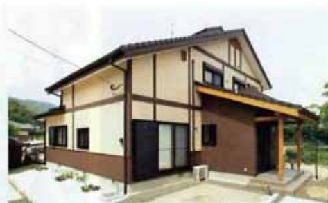
屋根上に見える小屋換気口がエアパス工法の証。ここを開け閉めして空気の流れをつくり、家を暖めたり冷やしたりしている
