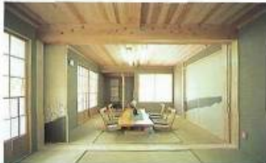
壁は全室とも珪藻土。和室の壁は藁を練り込んでおり風合いも面白い。建具はすべてオリジナルのもの
